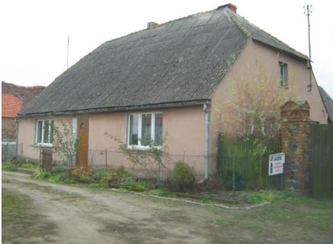
Rysunek 2. Budynek mieszkalny pokryty płytami azbestowymi falistymi niemalowanymi
